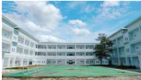
Gambar 2. Bangunan Belakang Rumah Perlindungan Sosial Kota Medan
